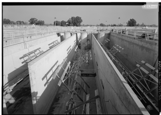
Vasche di flocculazione svuotate per le operazioni di manutenzione. Sono visibili gli agitatori.
