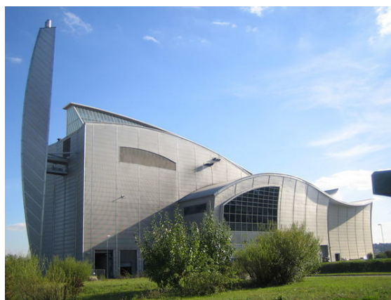
Impianto di produzione di energia elettrica da combustione dei fanghi.
