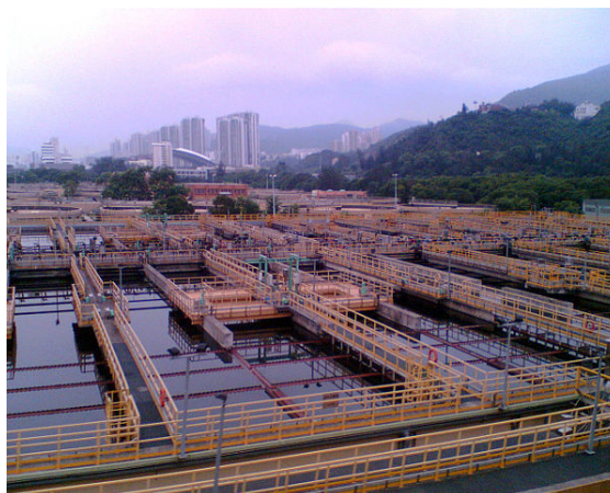
Immagine di un impianto trattamento acque reflue
