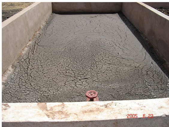
Letto di essiccamento dei fanghi
