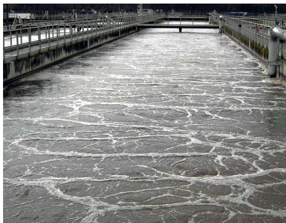
Impianto a fanghi attivati con microbolle
