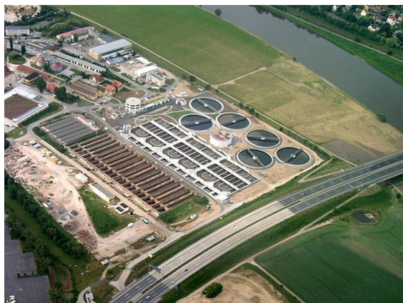
Vista aerea di un impianto di depurazione delle acque.
