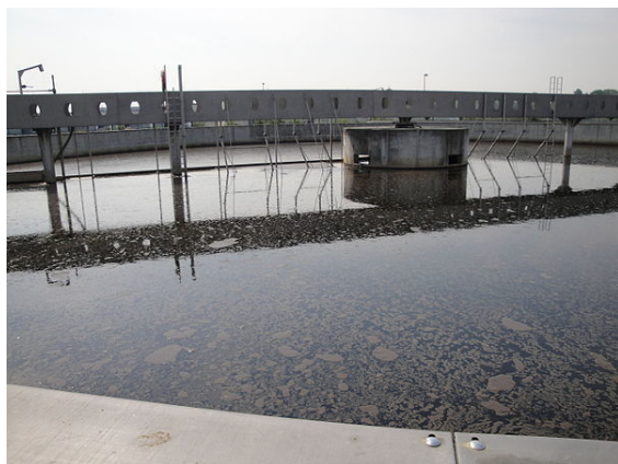
Vasca di sedimentazione secondaria
