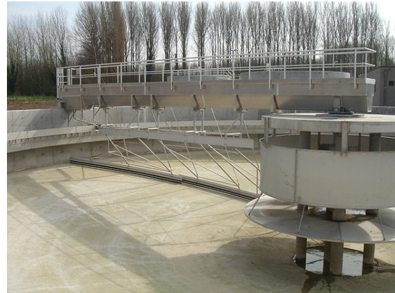
Vasca di sedimentazione.
